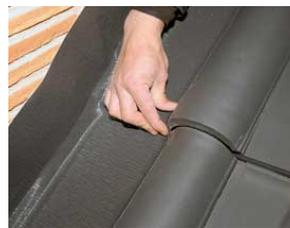
Moldeado y fijación mediante presión.
