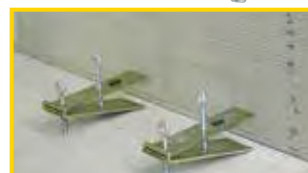
1º Posicionar niveladores.
