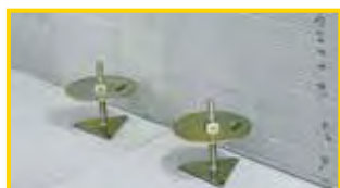
1º Posicionar niveladores.
